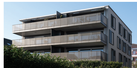
Ensemble d'immeubles à la rue des Pralaz à Peseux a été réalisé par Masini.
